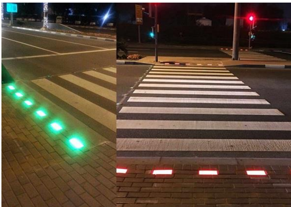
Рисунок 2.7 – оснащение пешеходного перехода на улично-дорожной сети Дубая ОАЭ, пропуск пешехода (фрагмент слева), режим ожидания пешехода, беспрепятственный пропуск транспортных средств (фрагмент справа)
