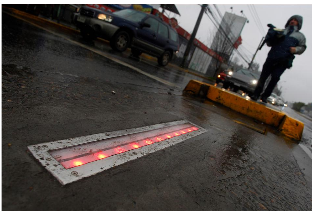
Рисунок 2.6 – пример «in-ground traffic-light technology», Консепсьон, Чили
