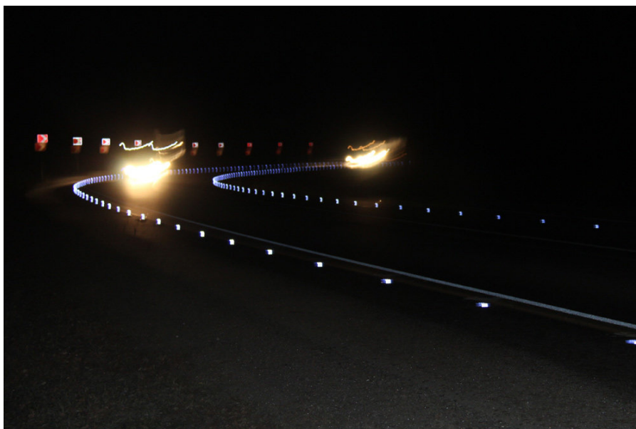
Рисунок 3.4 – Участок неосвещенной магистрали, оснащенный дорожными индикаторами
